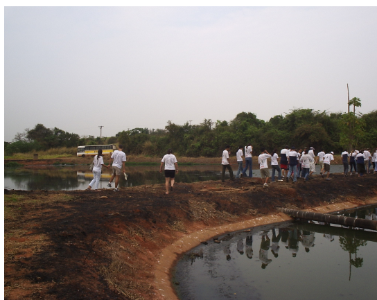
Figura 5. Lagoa de repouso do esgoto urbano, antes de ser lançado no córrego Jacutinga (afluente do rio São José)
