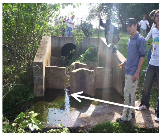
Figura 6. Entrada clandestina de esgoto urbano (Córrego Água Limpa)
