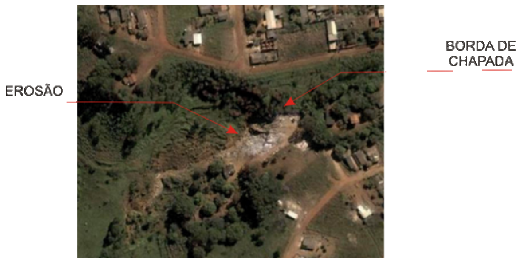
Figura 4 – Erosão em 2005, houve uma redefinição dos taludes da erosão, provavelmente devido ao movimento de massa, é possível perceber ainda na imagem a grande quantidade de lixo depositado dentro dela. É comum em Anápolis esse tipo de medida como tentativa de contenção da erosão.
